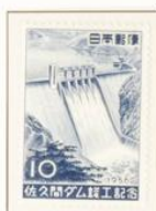
1956 - Terminación de la presa de Sakuma
