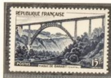
1952.—Viaducto de Garabit
