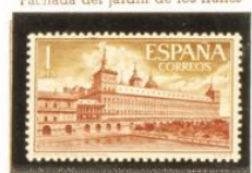
Fachada del jardín de los frailes
